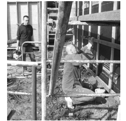
Samu auf der Baustelle
